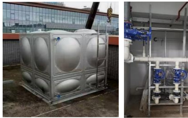
● 尾水回收利用设施及雨水回收设备
