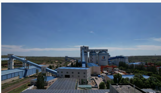
厂区内的分布式光伏项目
