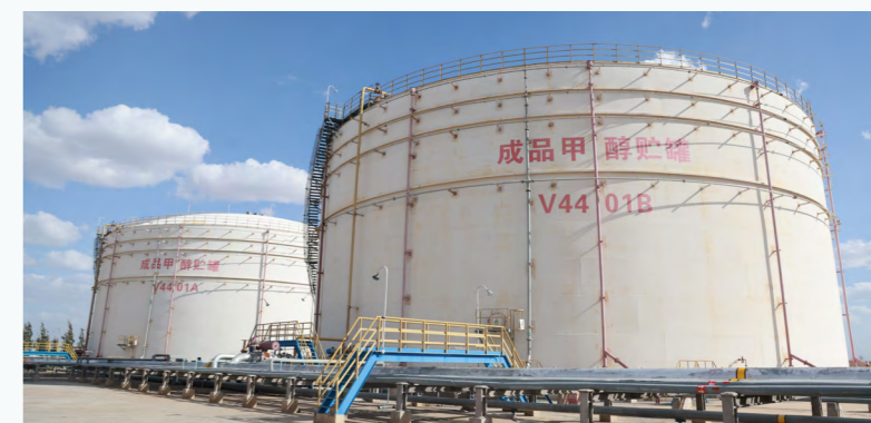
成品罐区 AI 巡检系统投入使用
