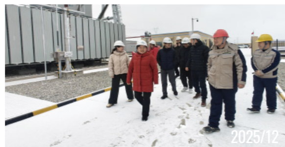
独立董事赴和田地区实地调研储能项目
