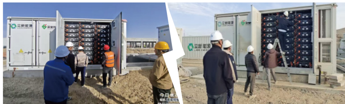
和田市 100兆瓦时 /400兆瓦时独立储能项目质量检查
