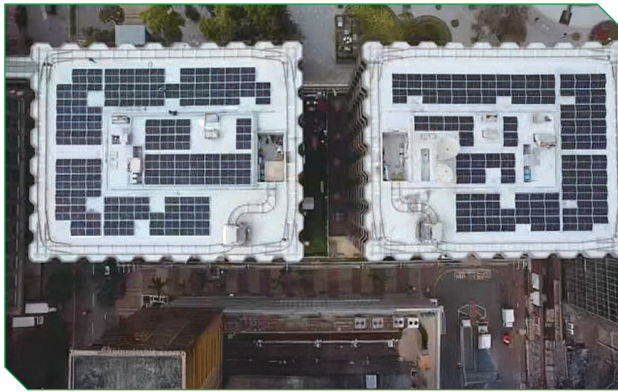
九龍尖沙咀南洋中心屋頂光伏項目於2024年2月並網發電，設計發電裝機容量為194千瓦，是本集團於香港的第13個光伏項目。
