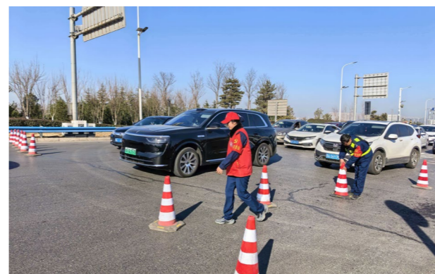
春运保通渠化车道
