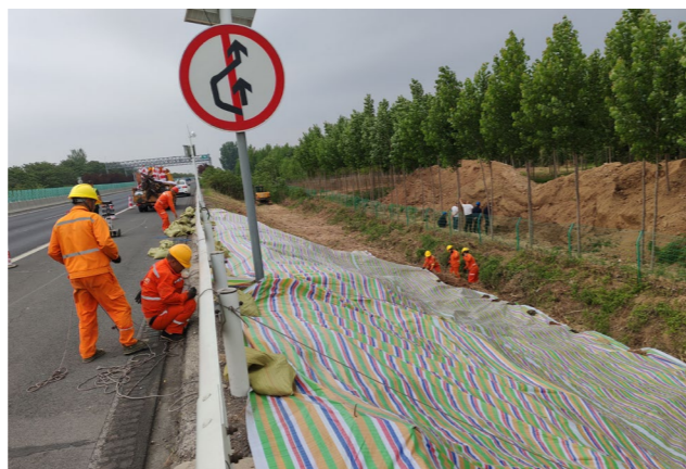
路基涌水应急处置
