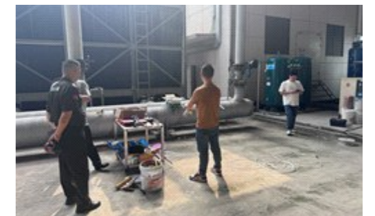
安全隐患排查
