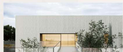
外墙干挂自洁板
