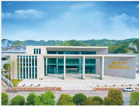
微玻纤国际技术中心（实景）
