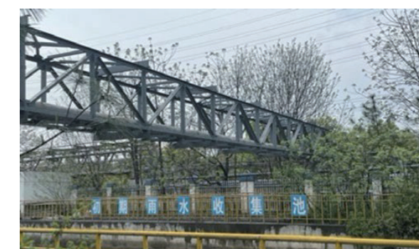
初期雨水收集池
