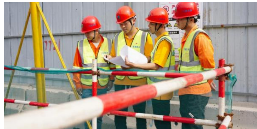
排水管理党支部东横河项目党小组施工现场
