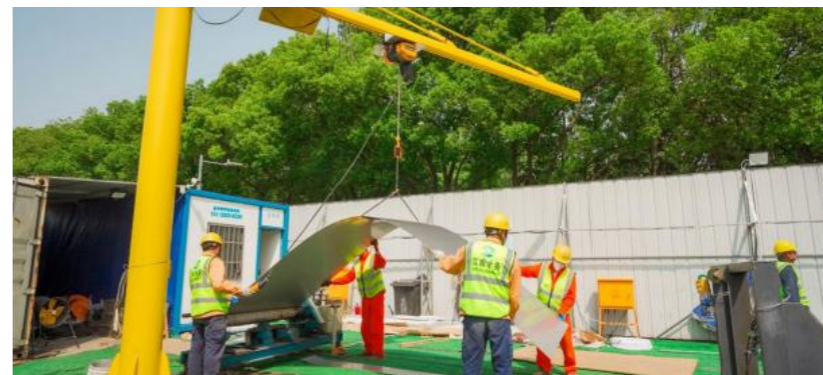
“公园路项目攻坚”党小组作业现场
