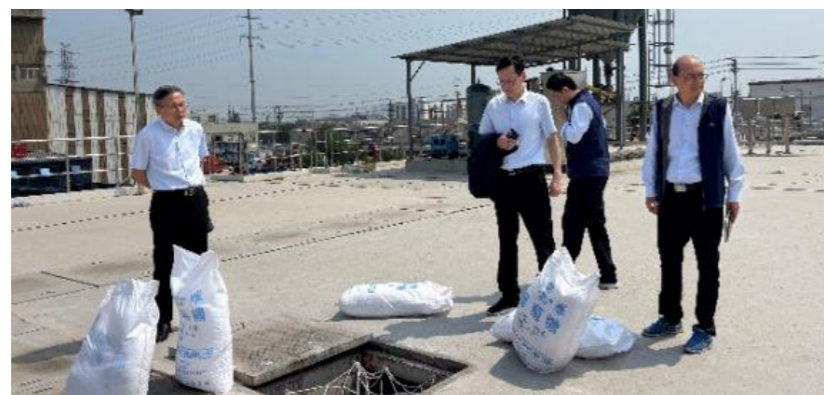
污水处理厂检查现场
