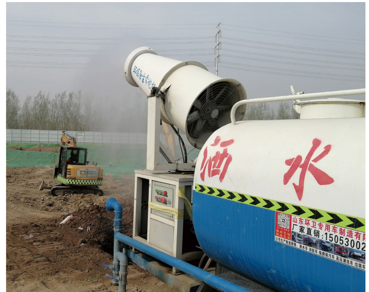
中電光谷建築設計院施工過程採用霧炮降塵
