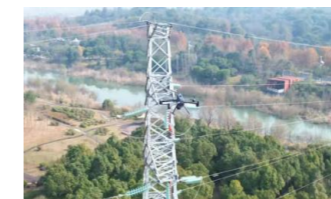
无人机电力巡检作业
