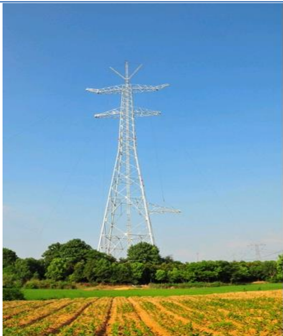
1000KV 特高压交流输电线路铁塔
