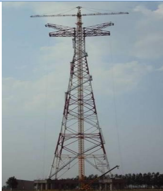
660KV 直流输电线路铁塔
