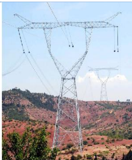
1000KV 特高压交流输电线路铁塔
