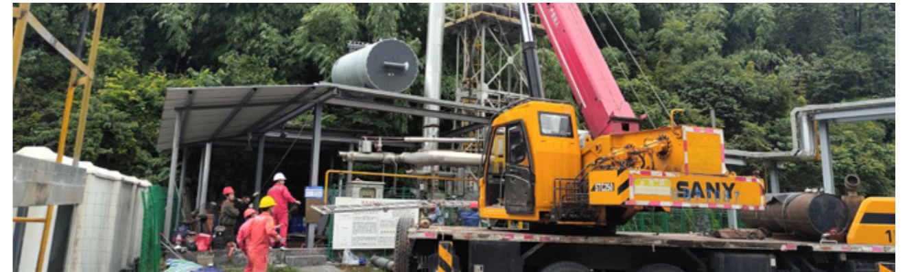
叙永森能低氮锅炉改造
