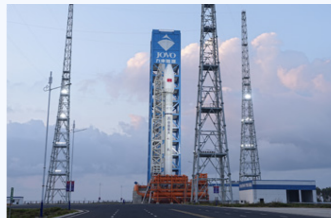
九丰能源海南商业航天发射场特燃特气配套项目
