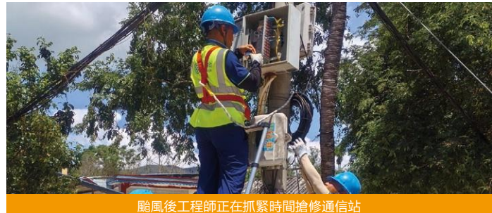
颱風後工程師正在抓緊時間搶修通信站
