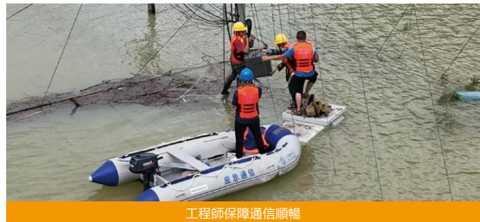
工程師保障通信順暢
