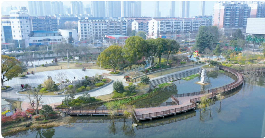
Zhenjiang Sponge City Construction Public-Private-Partnership (“PPP”) Project 鎮江海綿城市政府和社會資本合作（「PPP」）項目
