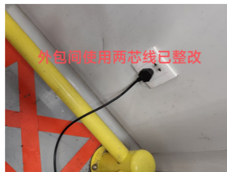
(整改后) 拆除花线，更换三芯阻燃电缆 (RVV) 并可可靠接地
