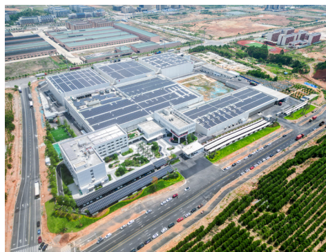
大咖國際廣西生產基地的光伏鋪設 Photovoltaic Installation at Daka International Food Co., Ltd. 's Guangxi Production Base
