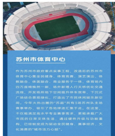
图注：苏州市体育中心项目
