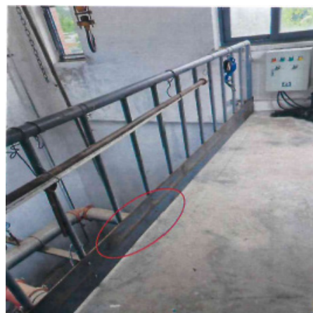
整改后 消防水泵房平台护栏 加装踢脚板
