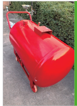
新增大容量半固定式泡沫滅火裝置
