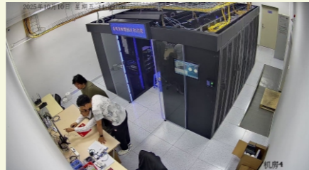
机房演练现场
