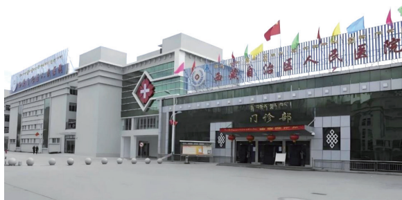
西藏自治区人民医院供配电改造提升项目
