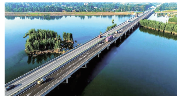
雄安市大清河治理工程（雄县段二期）剩余段
