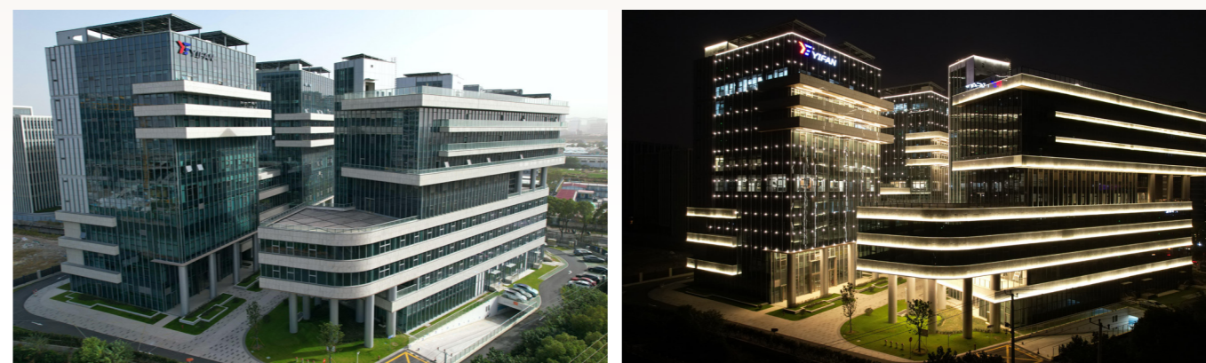
亿帆医药国际创新中心在上海建成落地
