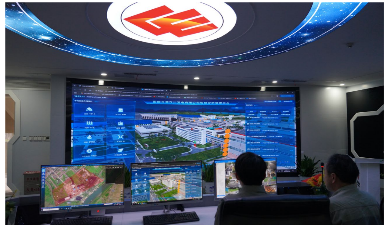
汉川公司智慧监控中心
