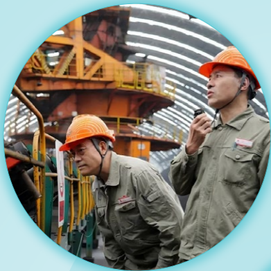
汉川公司 全力保障设备安全运行
