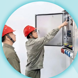
随州公司 全面排查整治设备设施隐患
