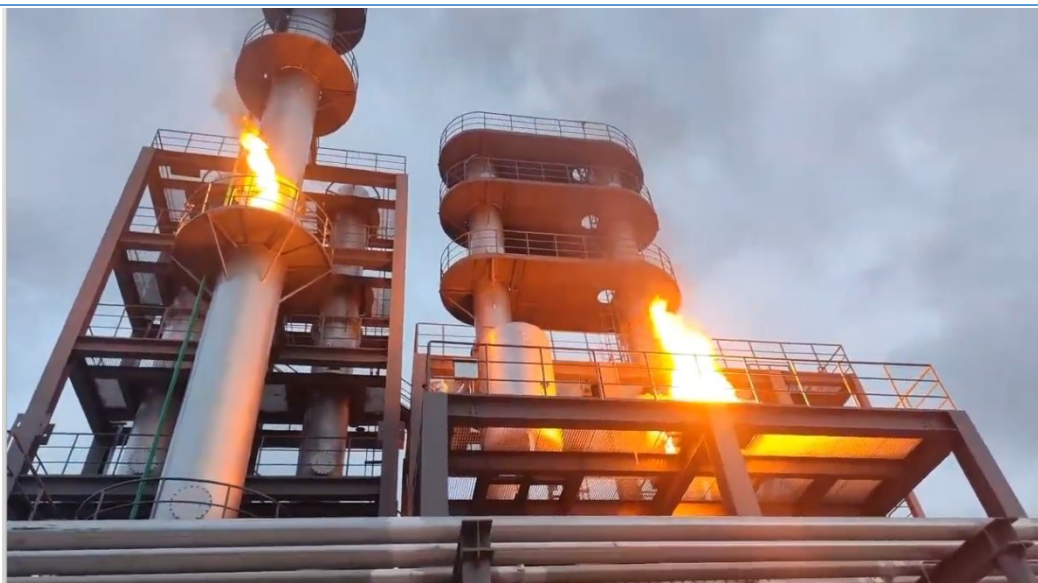
图 3 某基地真火项目交付验收现场
