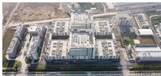
宁德生产基地光伏屋顶
