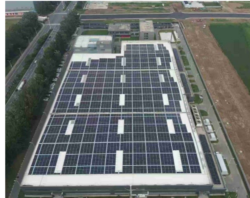
百斯图厂区光伏屋顶
