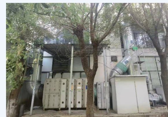
废气油雾&无极粉尘：经废气管路、静电除油设备 + 活性炭吸附装置处理后外排
