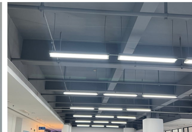
更换节能LED灯管照明
