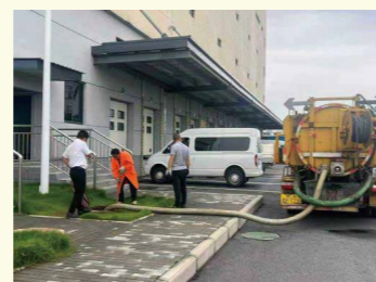
武汉物流对库区化粪池、隔油池进行清掏处理
