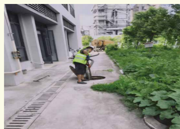
四川物流对库区化粪池、隔油池进行清掏处理
