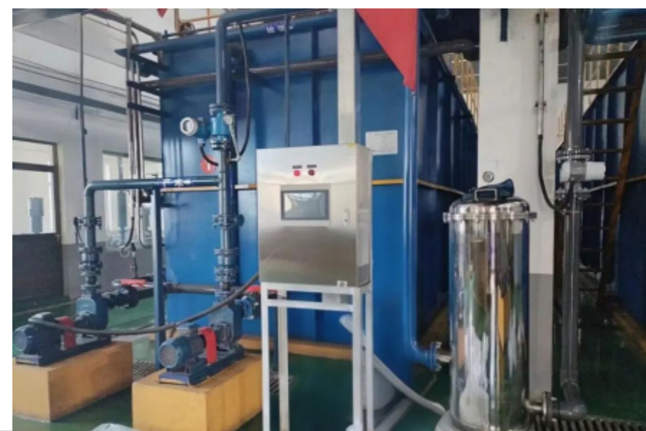
沁裕煤矿生产区生活污水处理站改造完成
