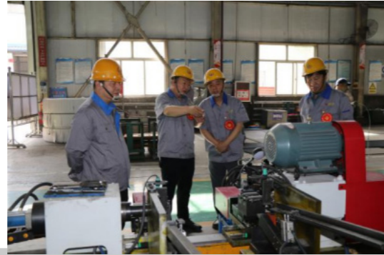
党员突击队托辊生产线升级改造项目
