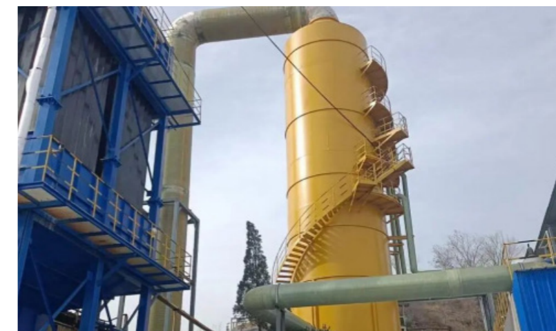
大阳煤矿老旧脱硫除尘器设备升级改造
