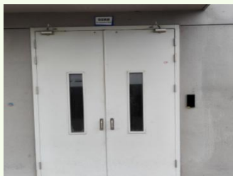
空压机设备单独设置机房隔绝噪声
