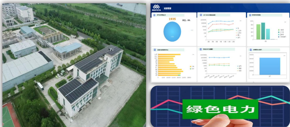
图：工厂屋顶光伏绿电项目
