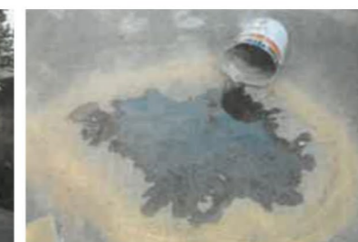
▲ 化学品泄漏后, 员工用黄沙进行封堵
