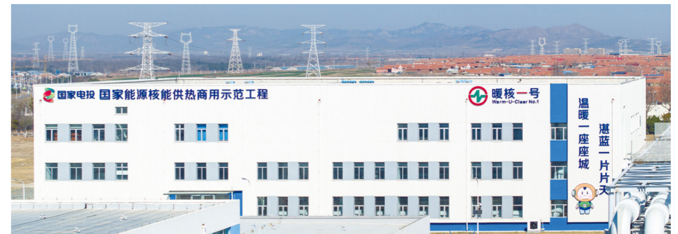
国家能源核能供热商用示范工程“暖核一号”核能供热项目联合泵站
