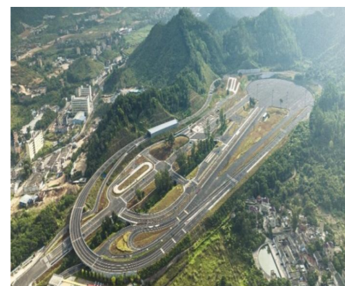
深圳坪山智能网联测试场
