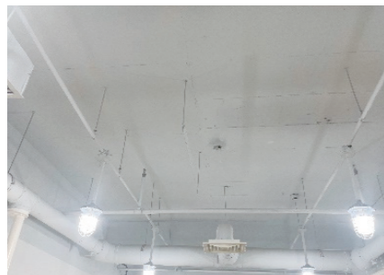
通风管线整改后
