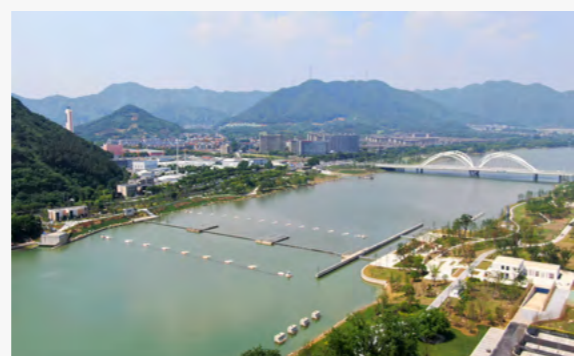
承建的杭州市富阳区北支江综合整治工程一下游水闸船闸工程
