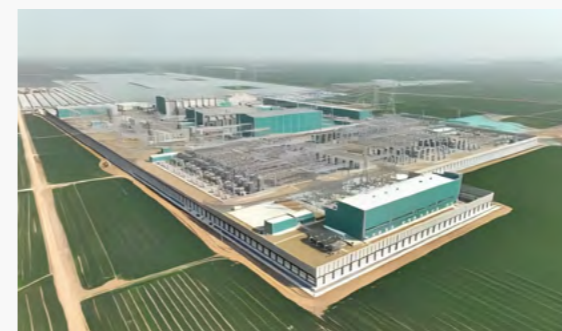
承建 2025 年度央企十大超级工程之一陇东—山东 ±800 千伏特高压直流工程
