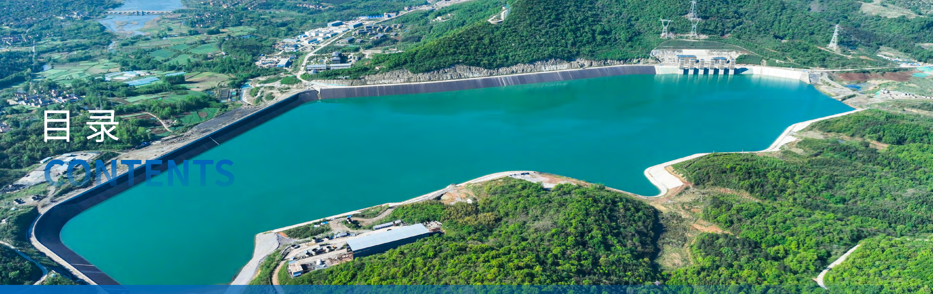
江苏句容抽水蓄能电站
