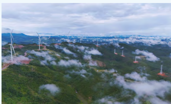
老挝孟松 600 兆瓦山地风电项目
