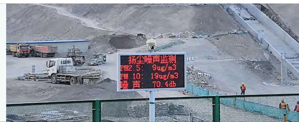
项目现场设置扬尘、噪声监测装置
