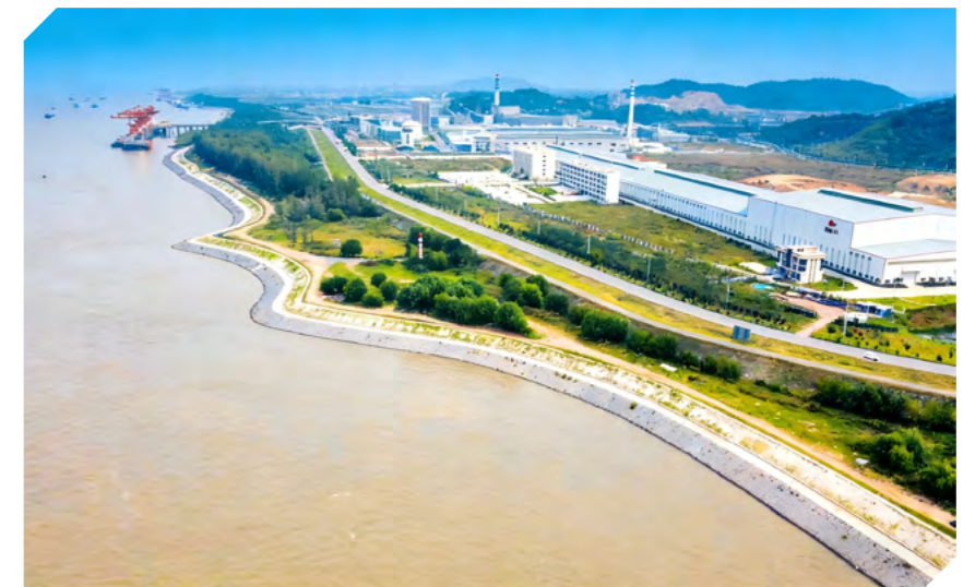
公司参建的长江干流江西段崩岸应急治理工程
