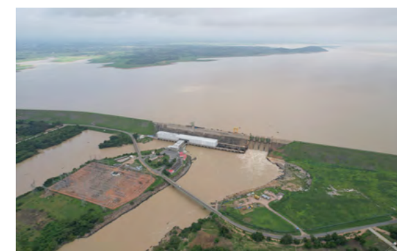
尼日利亚凯恩吉水电站
