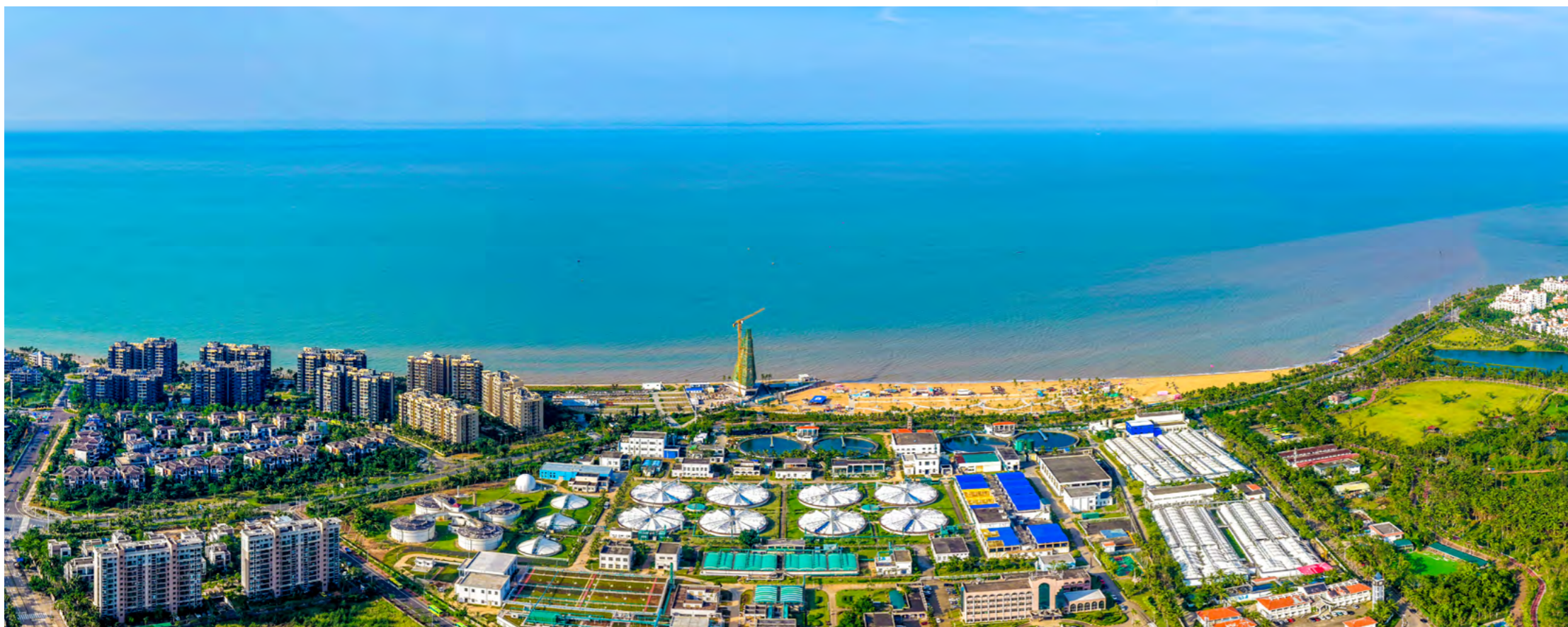
海南白沙门污水处理厂扩容项目
