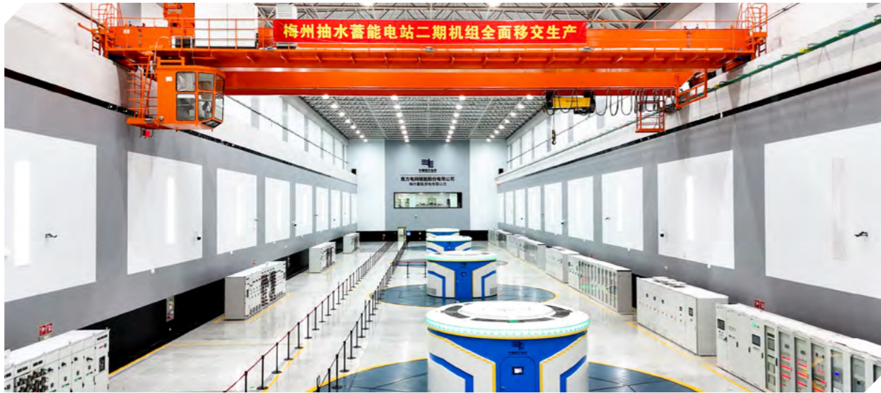
公司承建的梅州抽水蓄能电站二期工程
