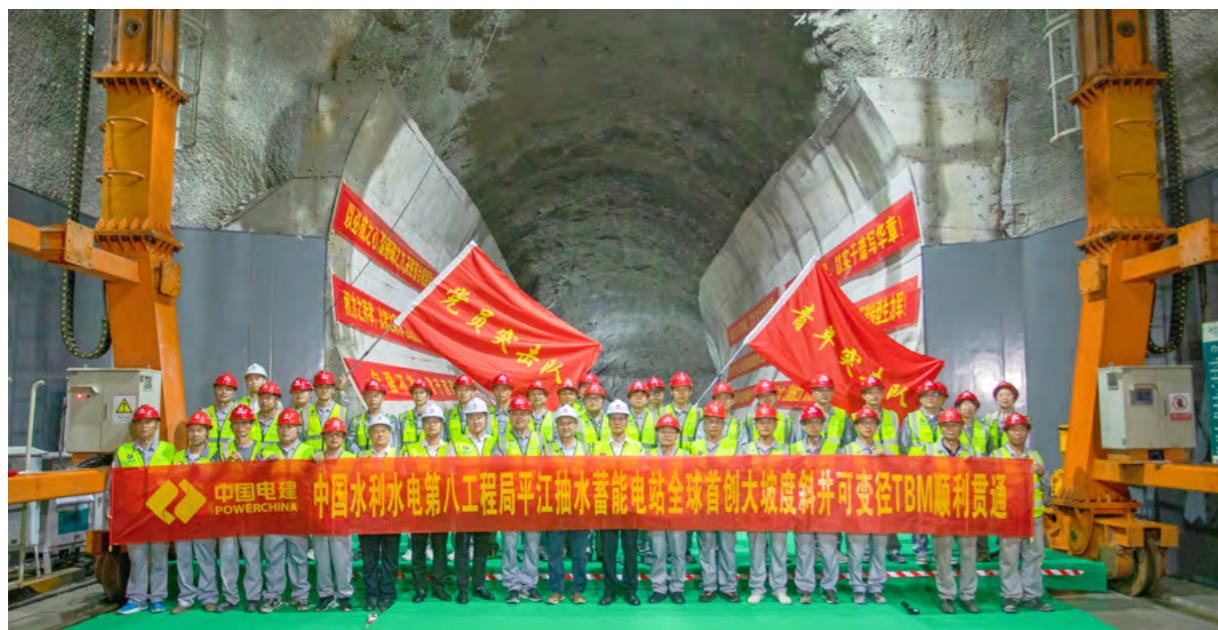
“天岳号”大倾角、可变径斜井 TBM 全线贯通
