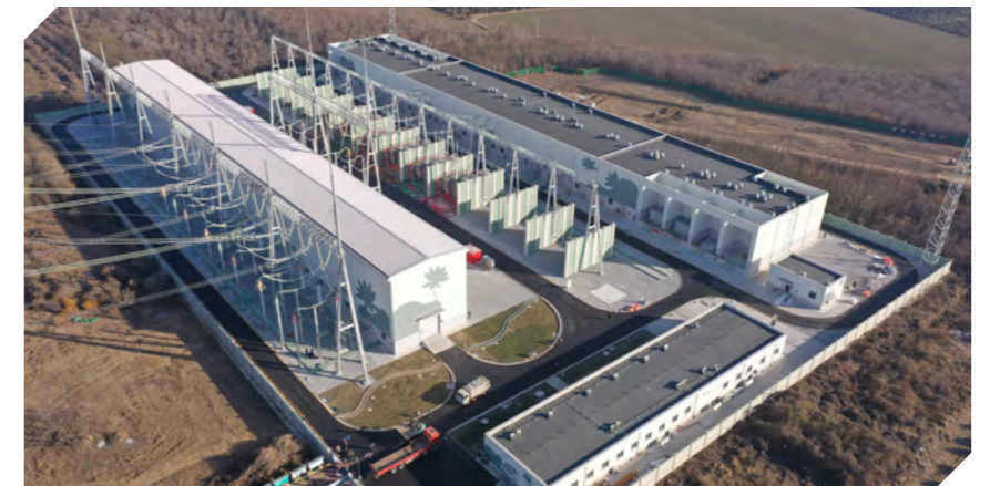
公司勘测设计的雄安 500 千伏变电站
