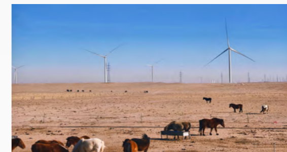
承建内蒙古能源乌拉特中旗 150 万千瓦风储基地项目
