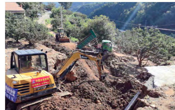
在河北省承德市兴隆县开展抢险救灾工作
