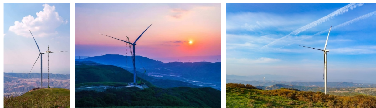
宁武盘道梁二期50MW风电项目
