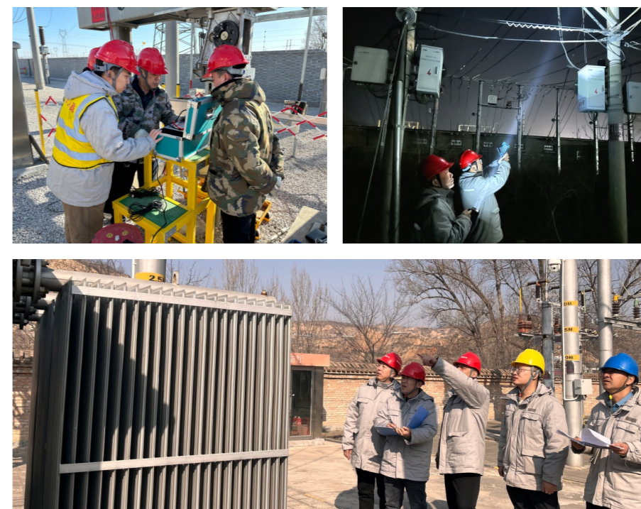
安全检修--守护万家灯火明
