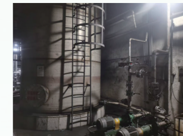
化纤公司实施远达制胶二车间糖 浓缩膜滤液回用项目
