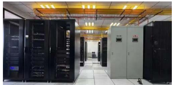
秦港股份電力公司開展800MHz數字集群系統軟硬件升級
