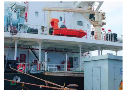
秦港股份七公司碼頭某輪正在進行低壓岸電連接
