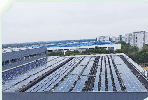
無錫工廠光伏鋪設
