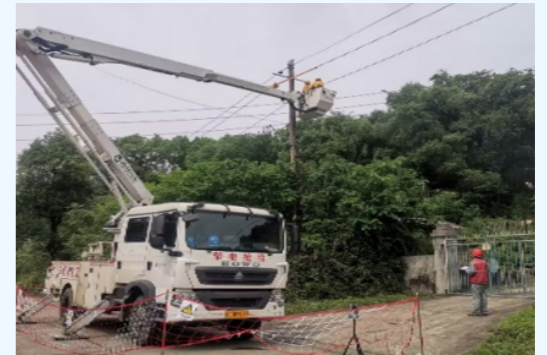
供电线路节能改造项目
