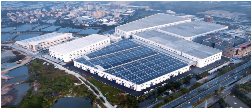
華南廠區光伏項目
