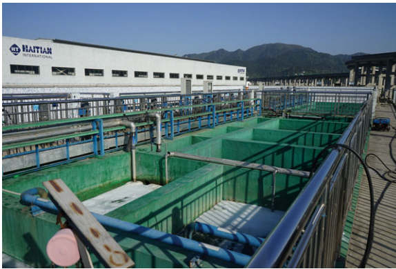
廢水處理站屋頂處理池
