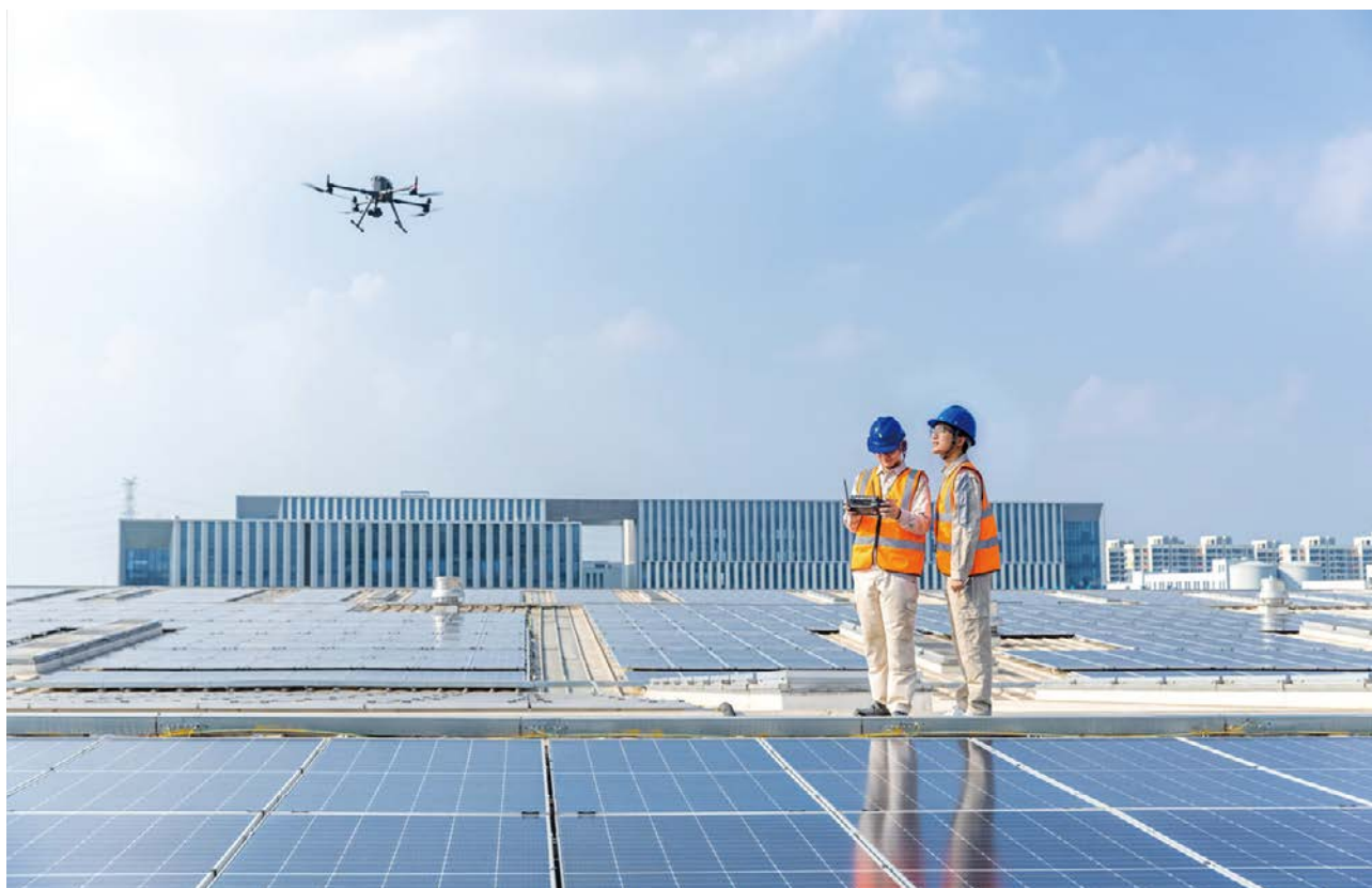
香港中華煤氣採用無人機進行AI智能巡檢，對設備狀態與環境風險實施高效監測，顯著降低了安全風險與巡檢成本。
