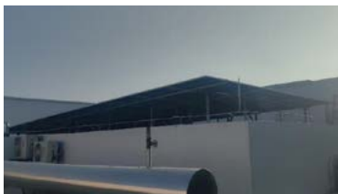
(附图：光伏组件铺设情况)
