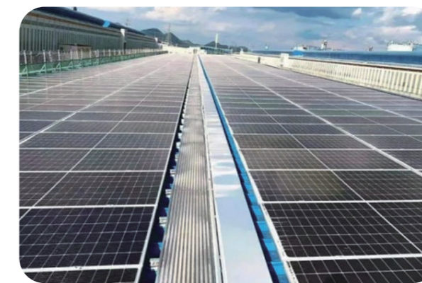
云南宏泰工厂屋顶安装光伏面板
