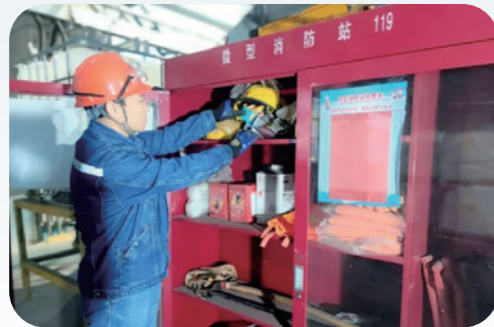
检查消防设施
