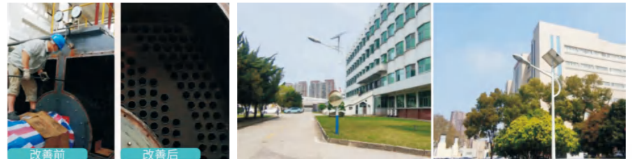
改善前 改善后 常态化锅炉清灰提高天然气利用效率
