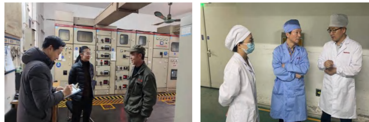
安全隐患排查
