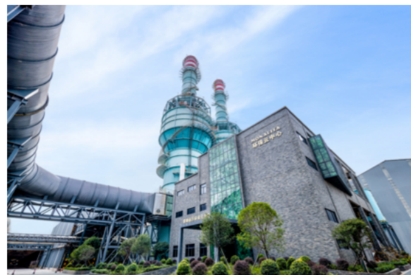
尾气处理装置
