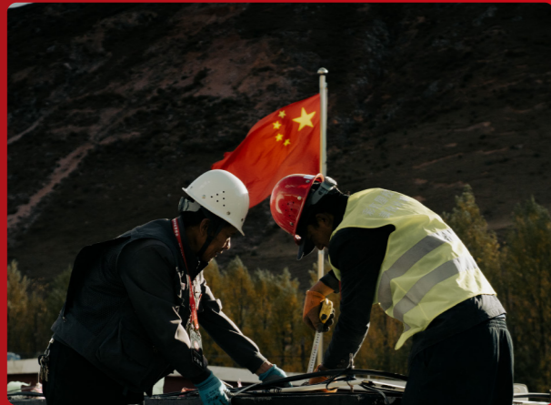
● “彩虹屋校舍美化”项目施工人员在学校屋顶修缮作业
